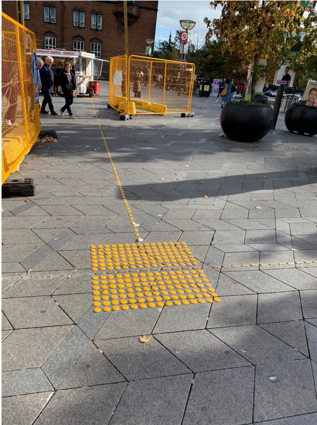
Figur 9.8 Den eksisterende ledelinje er spærret af byggepladshegn og der er etableret en midlertidig ledelinje omkring byggepladsen.
