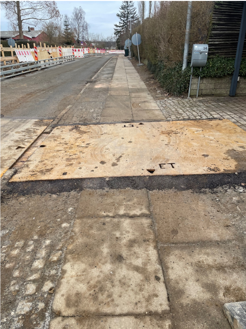
Figur 9.7 Jernplade over udgravning på fortov.
