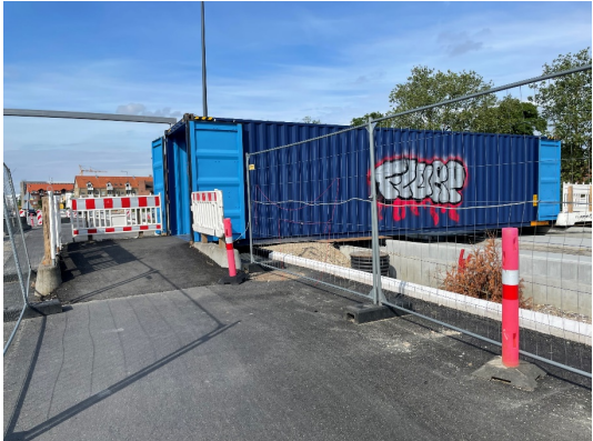
Figur 9.3 Container brugt til passage
