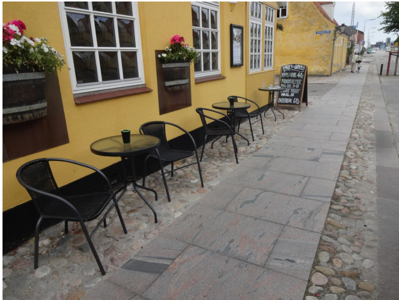
Figur 2.11 Jævn gangbane rammet ind af pigstensbelægning.
