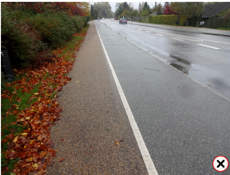
Figur 2.24 Delt sti med utilstrækkelig taktil adskillelse.
