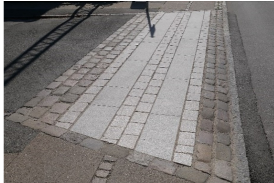
Figur 4.19 Overkørsel med gangbane i bordursten og savede og jetbrændte brosten.
