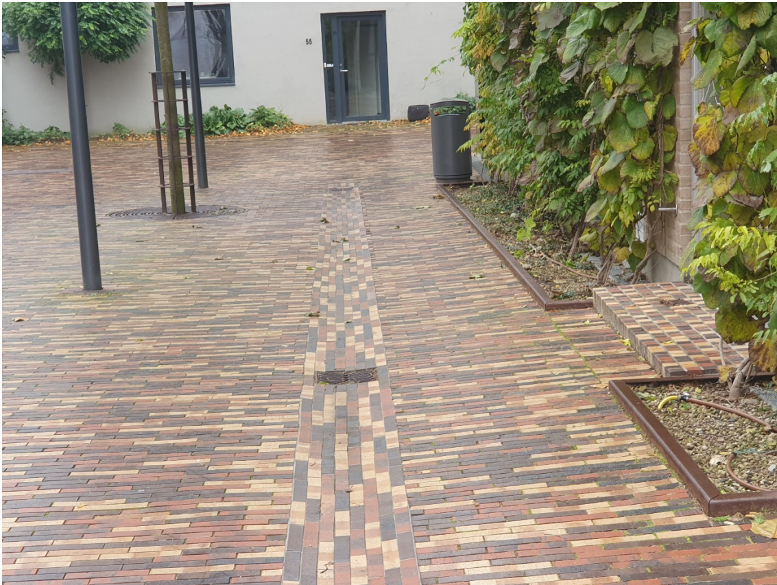
Figur 2.21 Flad vandrende, der kan passeres af gående og mennesker, der bruger hjælpemidler på hjul
