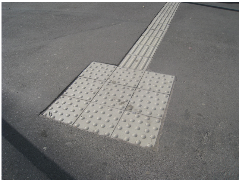
Figur 3.10 Opmærksomhedsfelt og ledelinje i lys beton, efter DSB-standard.
