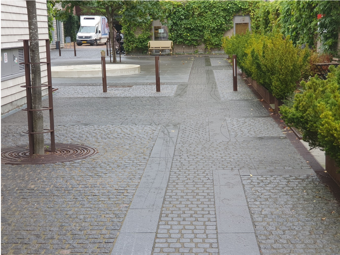
Figur 2.10 Jævn belægning af savede chaussésten og bordursten med fast fuge, der giver en jævn og skridsikker belægning
