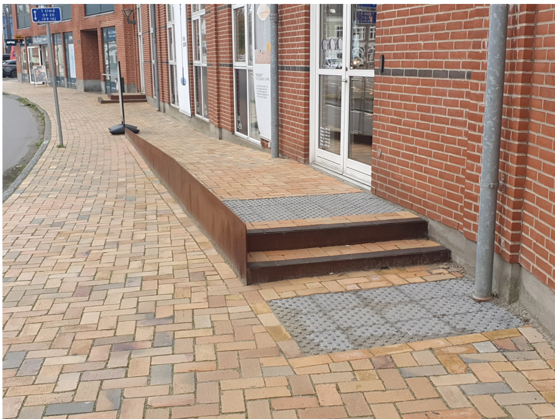
Figur 6.5 Kombineret rampe og trappe ved butiksindgang
