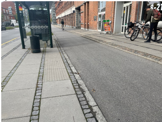
Figur 5.3 Nedsænket kantsten ved midterdør og høj kant ved retningsfelt
