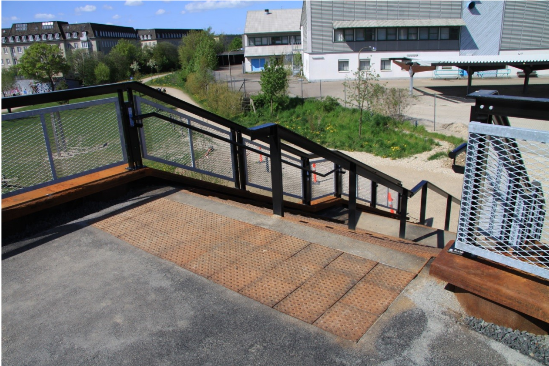
Figur 6.3 Trappeanlæg ved bro over metroen, Frederiksberg Kommune.
