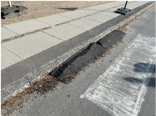
Figur 9.5 Midlertidig udligning af kantstensopspring
