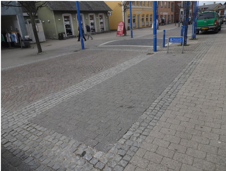
Figur 7.5 Handicapparkering, længdeparkering i anbefalet størrelse og niveaufri adgang.
