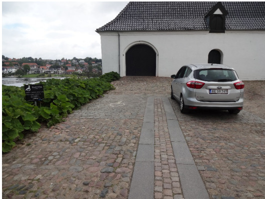
Figur 7.2 Ujævn belægning, mindre synlig markering og skiltning.
