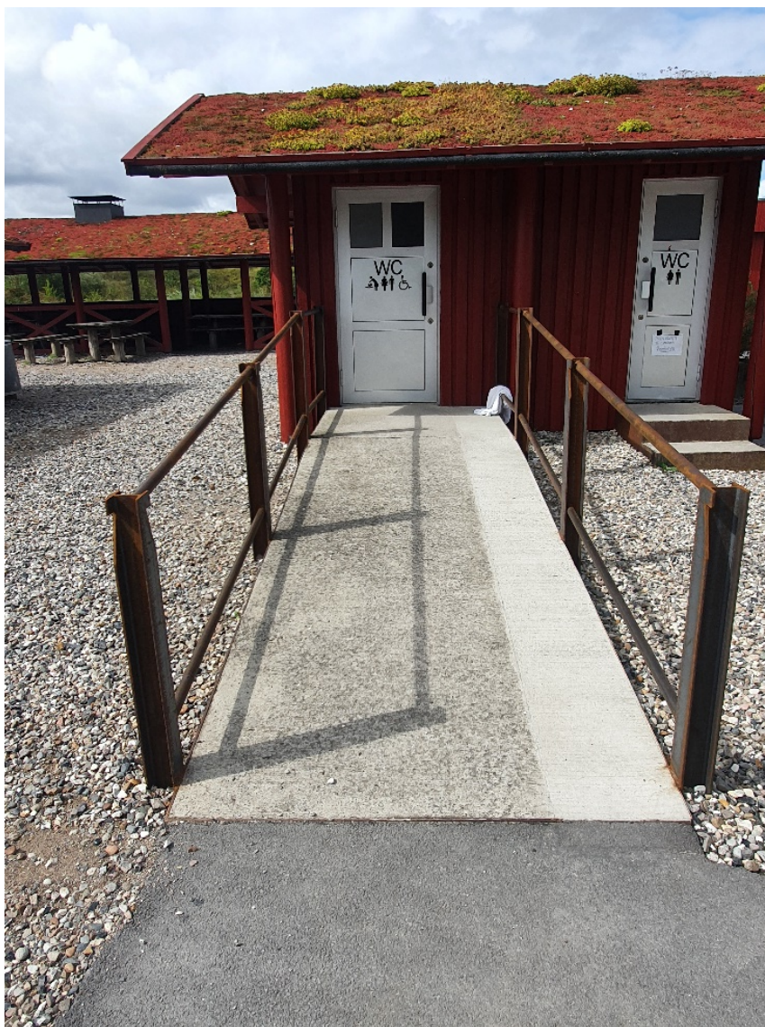
Figur 6.6 Rampe med hjulværn og håndliste op til handicптоilet
