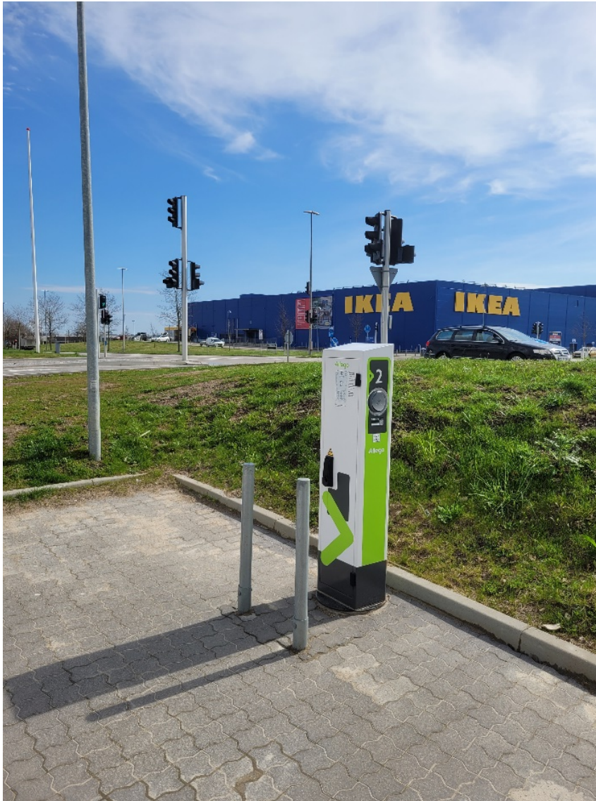
Figur 7.12 Almindelig ladestander uden ledning og med stolper som værn tæt på standeren. Ingen markering af en parkeringsplads. Rimelig plads ved ledningsudtag.
