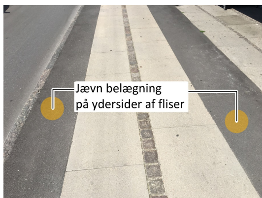
Figur 2.3 Københavnerfortov med asfalt i for- og bagkant.
