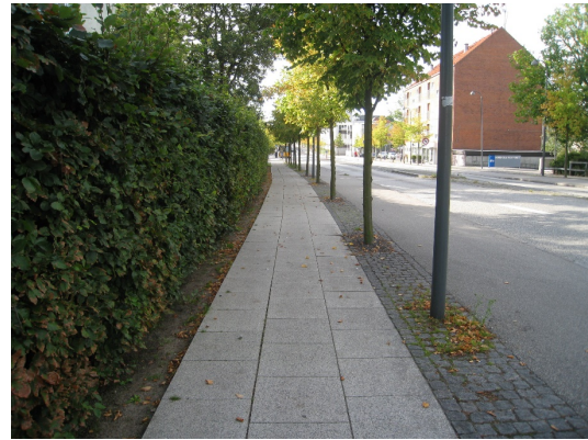
Figur 3.2 Flisekant i den ene side og ujævn belægning mod jævne fliser i den anden side.
