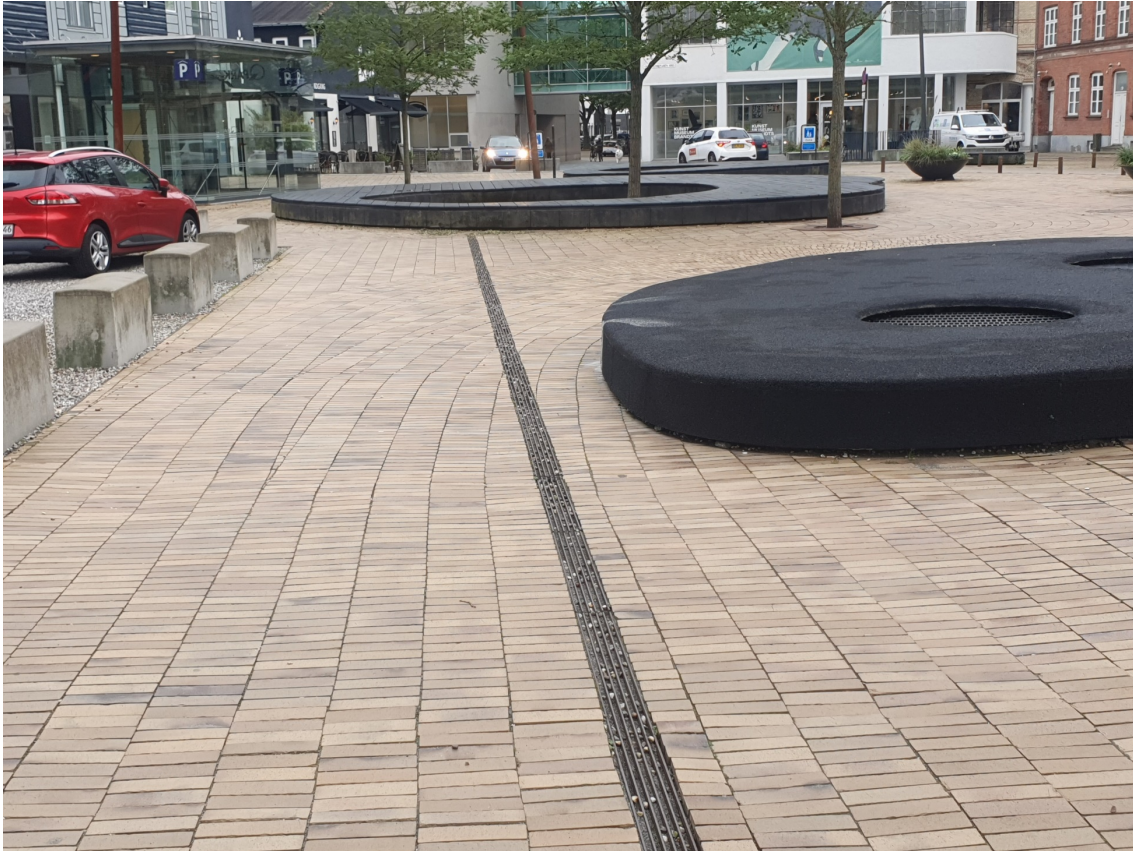
Figur 2.22 Vandrende med ribber, der kan passeres af gående og mennesker, der bruger hjælpemidler på hjul
