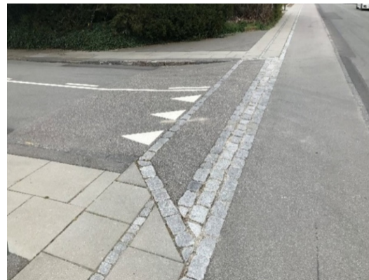
Figur 4.21 Smal overkørsel i asfalt.
