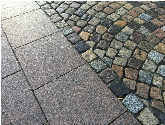
Figur 3.1 Jævne granitfliser mod ujævn chausséstensbelægning.
