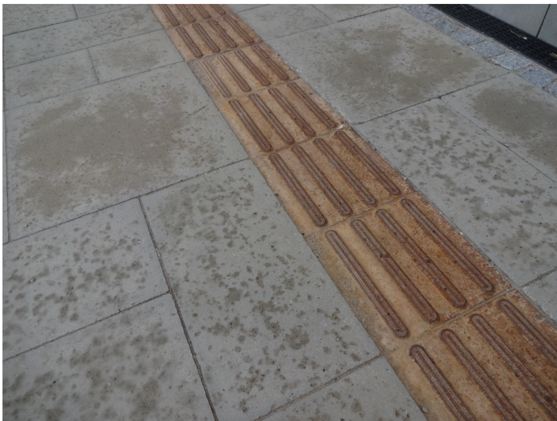
Figur 3.12 Nærbillede af støbejernsledelinje.
