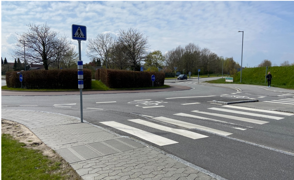
Figur 4.29 Fodgængerkrydsning i rundkørsel indrettet med taktil belægning
