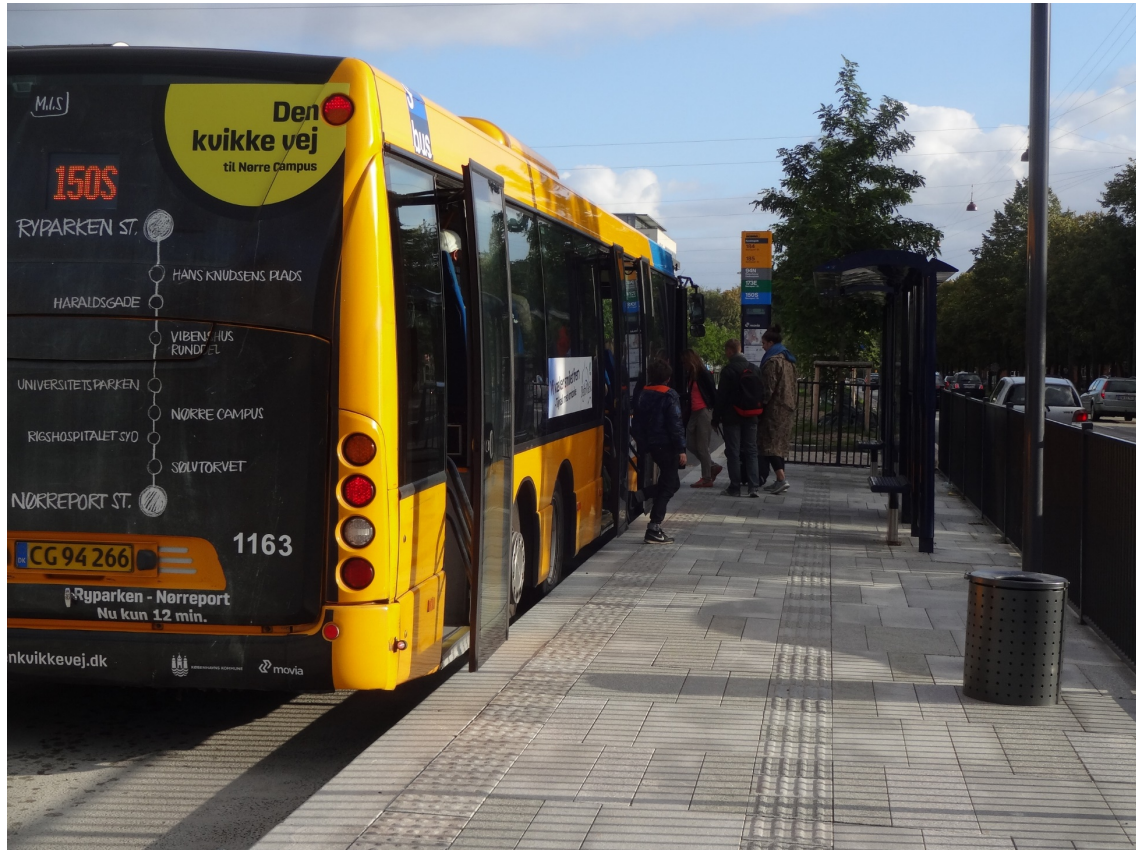
Figur 5.1 Hævet platform for lettere ind- og udstigning. Manglende visuel kontrast mellem taktile elementer og omgivende belægning. Begrænset plads til udstigning via rampe.
