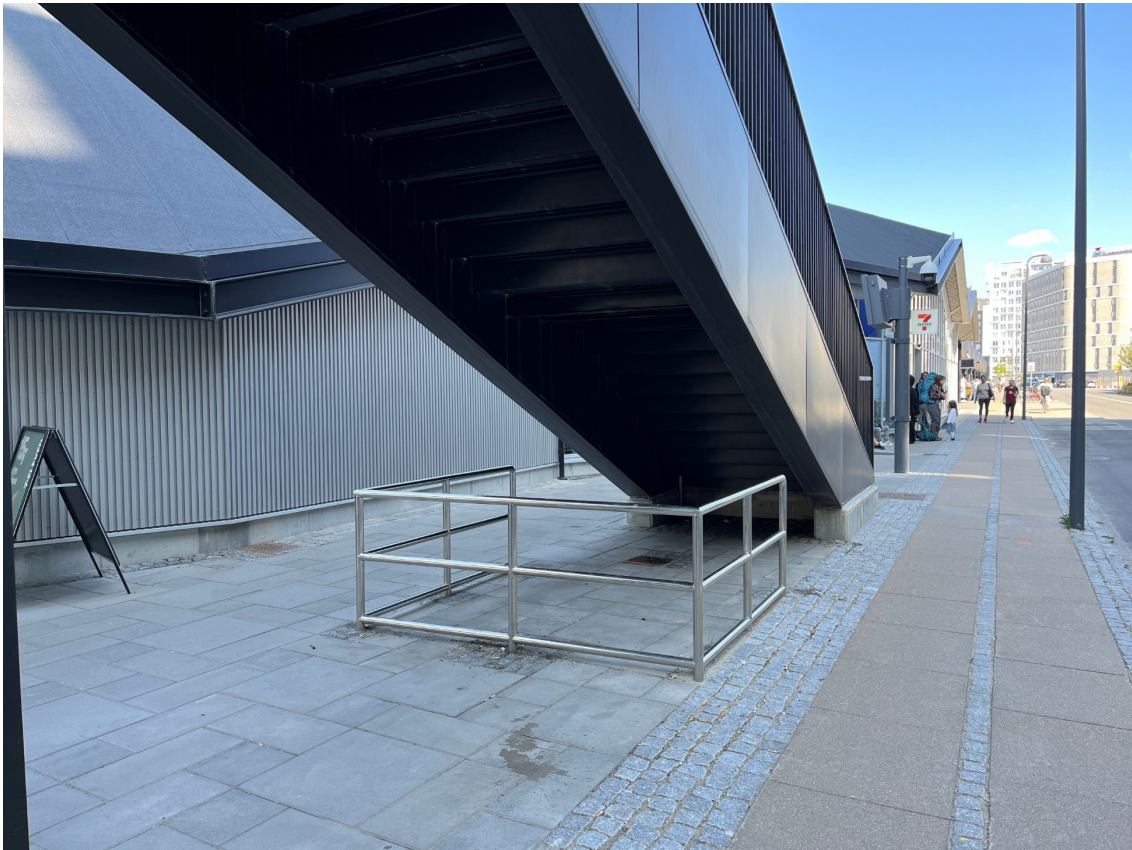
Figur 6.4 Underside af trappe er afskærmet med værn
