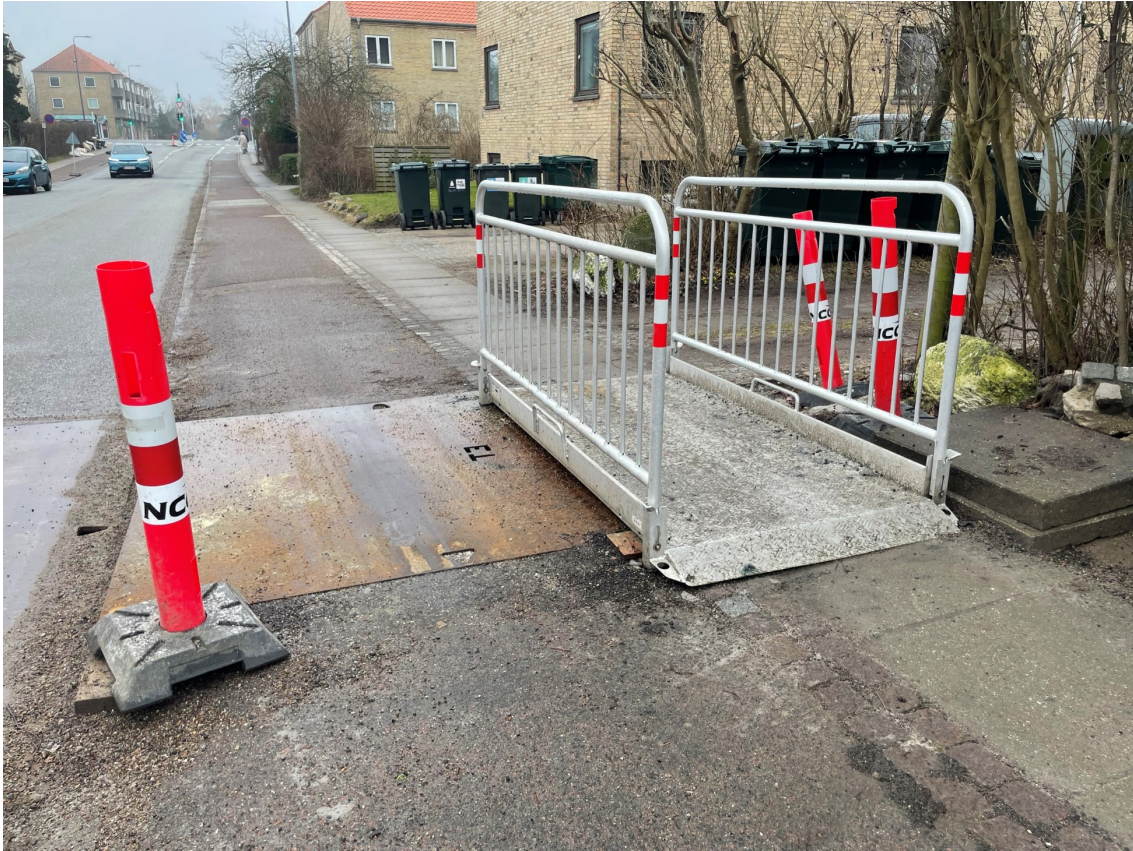
Figur 9.6 Gangbro over udgravning på fortov
