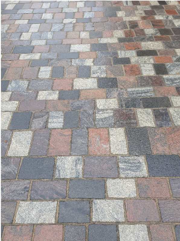
Figur 2.9 Brostensbelægning med fastefuger
