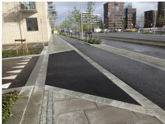
Figur 4.20 Overkørsel i asfalt.
