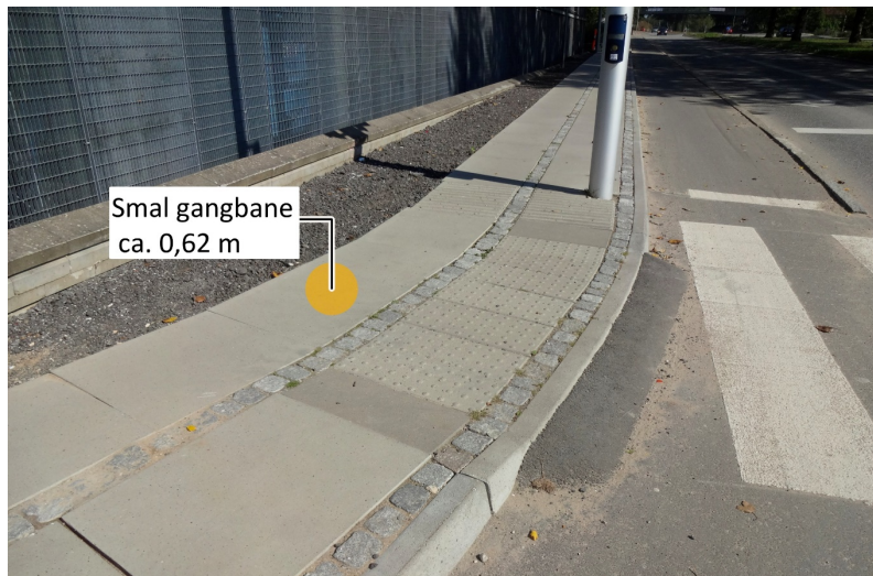
Figur 4.7 Smal gangbane med jævn belægning grundet opmærksomhedsfelt.
