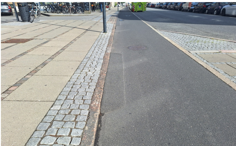
Figur 4.28 Udligning af niveauforskel
