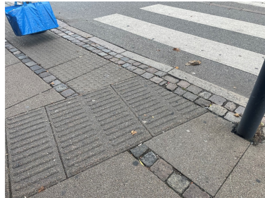
Figur 4.5 Opmærksomhedsfelt er ført helt hen til retningsfelt, da opspring her kun er 6 cm
