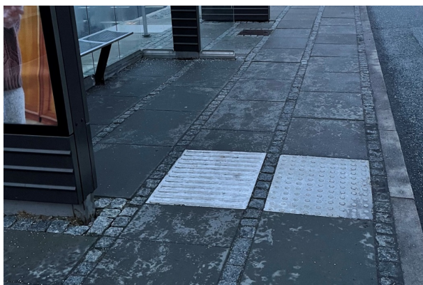
Figur 3.22 Taktil markering med god visuel kontrast, også i tussmørke
