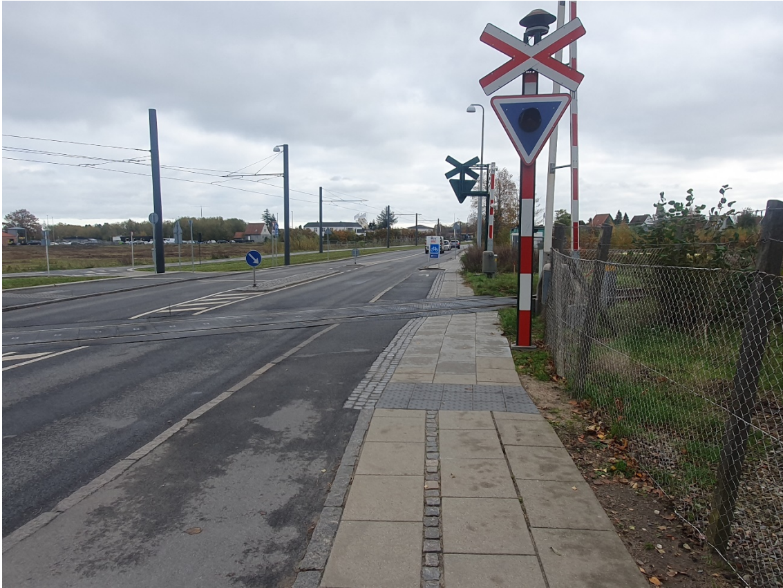
Figur 3.20 Opmærksomhedsfelt foran bomanlæg ved jernbaneoverskæring
