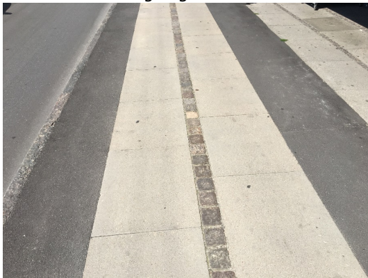
Figur 3.3 Chaussésten i Københavnerfortov.
